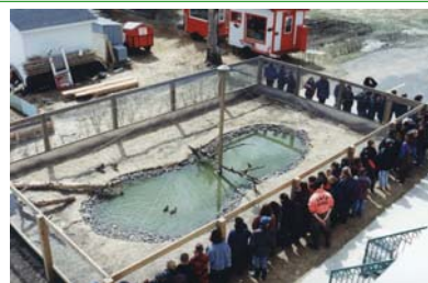
Volière construite par SARCEL
